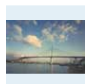
017. 荒津大橋 ▶中央区那の津～荒津
