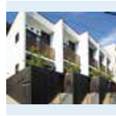
184. モジアアパートメント ▶南区多賀
