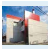
156. 博多消防団 那珂分団車庫 ▶博多区竹下
