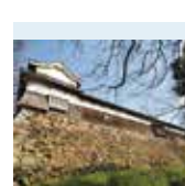
180. 国指定重要文化財 福岡城南丸多間櫓 ▶中央区城内
