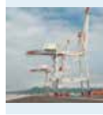
122. アイランドシティ コンテナクレーン
